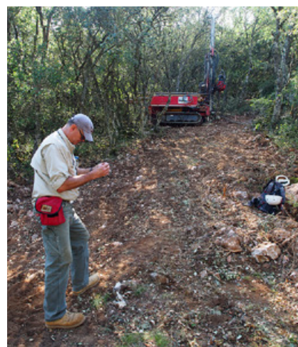
Perforación con recuperación de testigo, realizada en 2017, sobre el acceso original a la Galería de las Estatuas. FOTO: Ana Isabel Ortega
