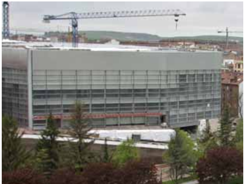
Las obras se adjudicaron en 2006 por apenas 50 millones, siendo 75,2 millones el presupuesto final que se prevé. / ECB
