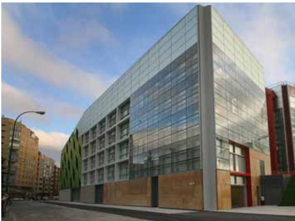
Aspecto del edificio del CENIEH desde el extremo que da a la calle Doctor Fleming. / ISRAEL L. MURILLO
